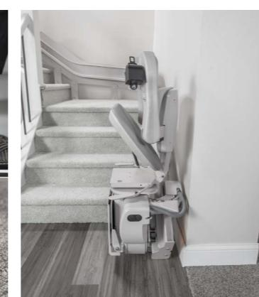
Sicherheitssensoren sorgen dafür, dass der Lift automatisch stoppt, sobald sich ein Hindernis auf der Fahrbahn befindet.
